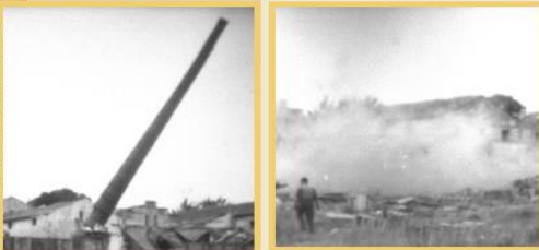
Fotos: Derribo de la chimenea Alcolholera Bruned.
