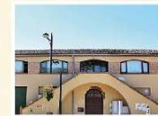
16 FÁBRICA TEXTIL Y VIVIENDA FAMILIAR DE CERRANO GUTIÉRREZ TAPA
