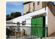
25 ALMACÉN FÁBRICA DE ACEITES DE ORLUD VDA. DE BERNARDINO CHEVAS Y VIVIENDA FAMILIAR DE VDA. DE D. IRIBARRE MARTÍNEZ E HIJOS
