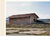
18 ESTACIÓN DE LA HAYA
