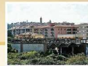
1 NAVE DE MÁQUINAS DEL FERROCARRIL
