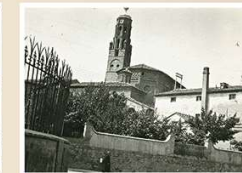
Vistas exteriores de la fábrica. Propiedad Angélica Pelón.
