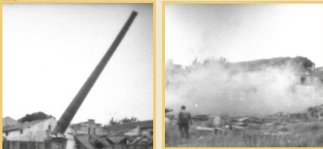
Fotos: Derribo de la chimenea Alcoholera Bruned.
